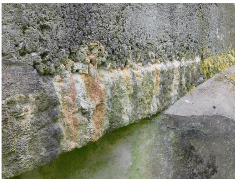
Zatékání mezi betonovou a kamennou částí levé římsy
