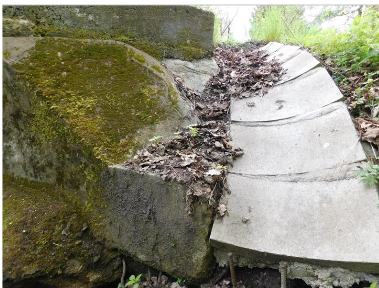
Odvodňovací žlab na levé straně u opěry OP1
