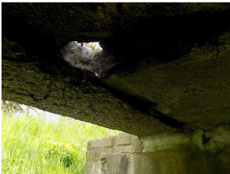
Rozpadlý beton desky pravého rozšíření
